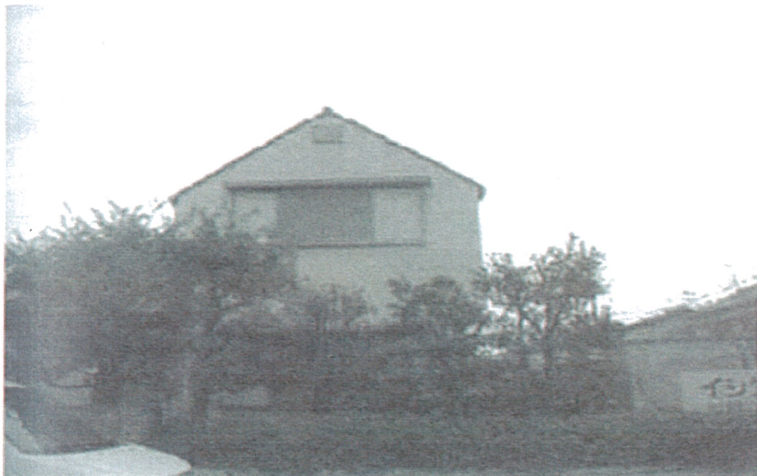
写真 No.1 東側外観
