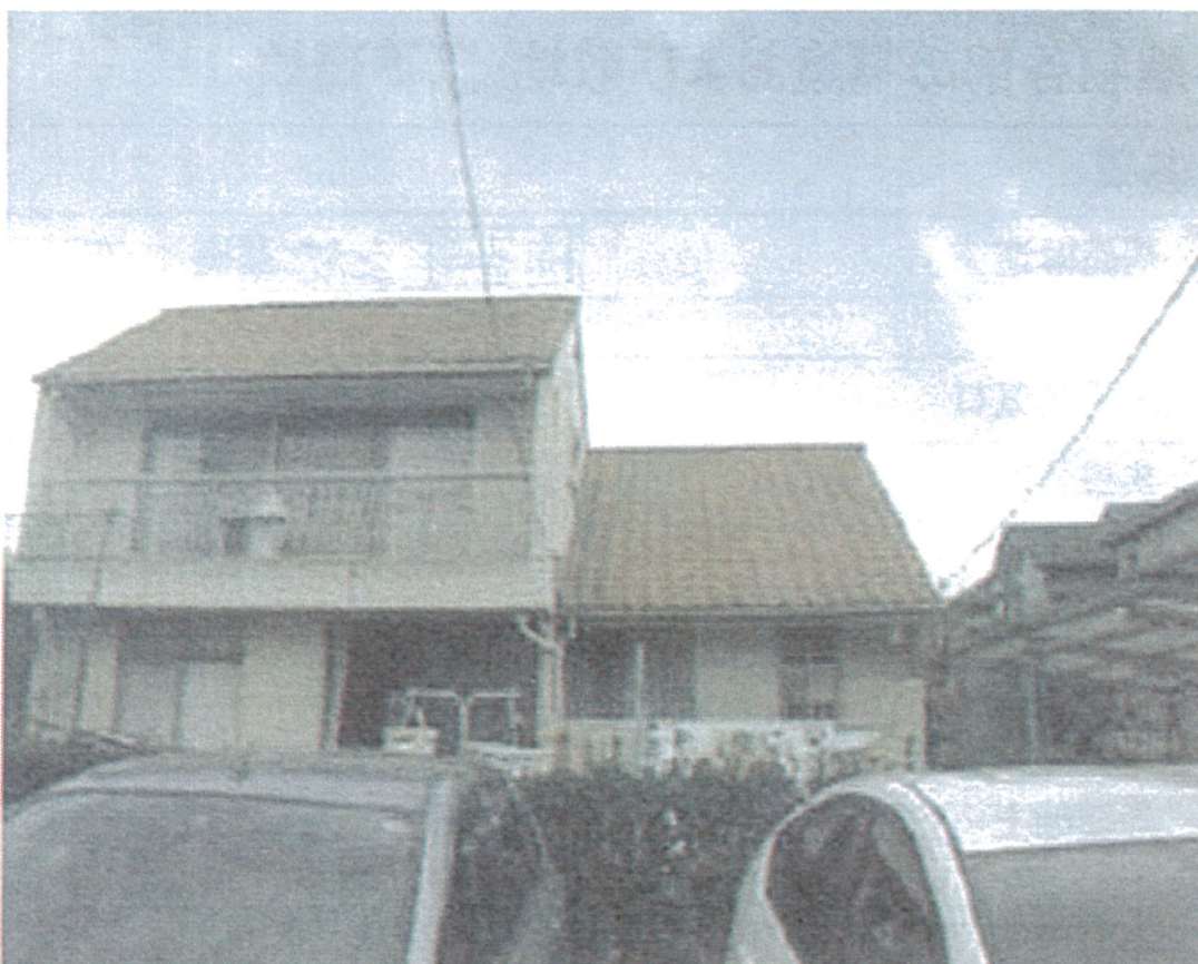
写真 No.2 南側外観
