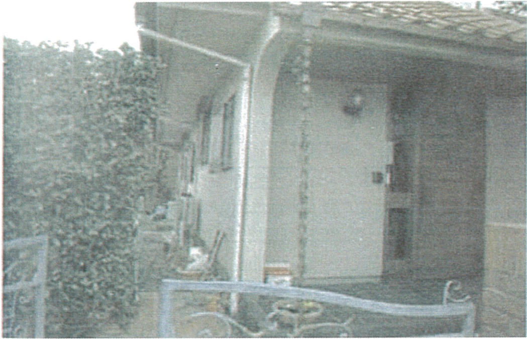
写真No. 3 玄関周り
