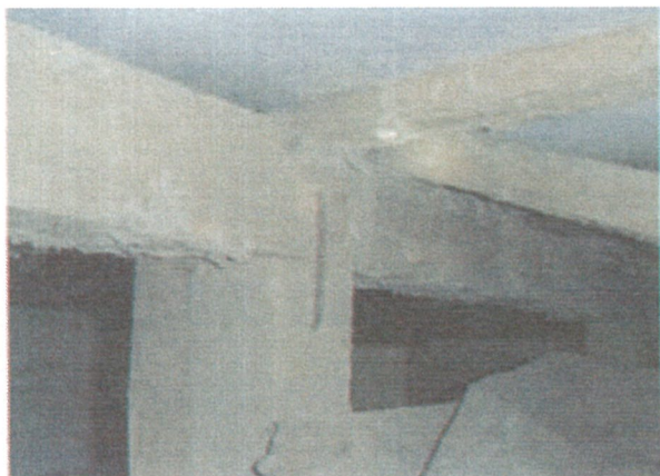
写真4 台所大引の蟻害
