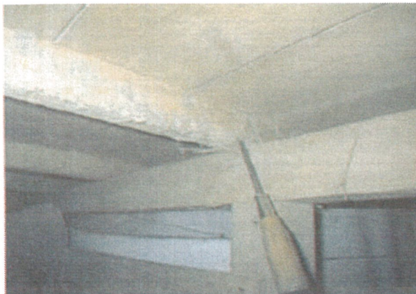
写真6 台所根下の蟻害
