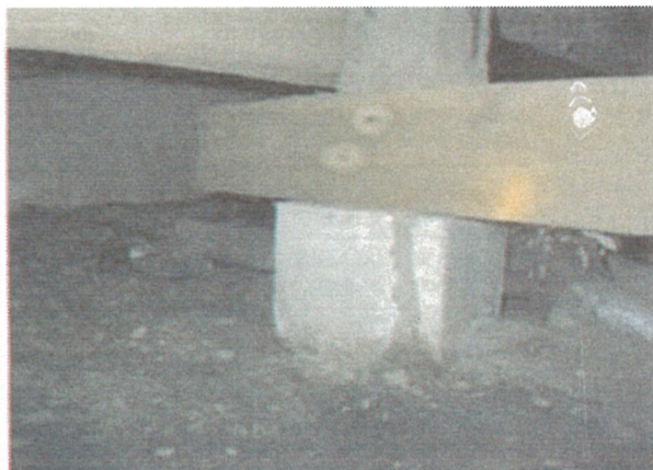
写真7 和室東石の蟻道
