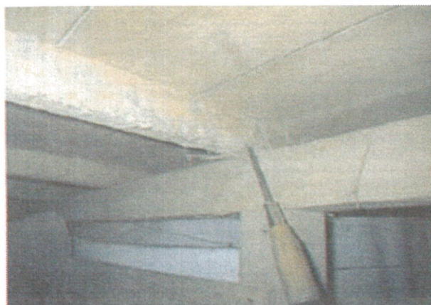
写真6 台所根下の蟻害
