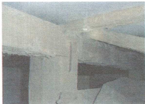
写真4 台所大引の蟻害
