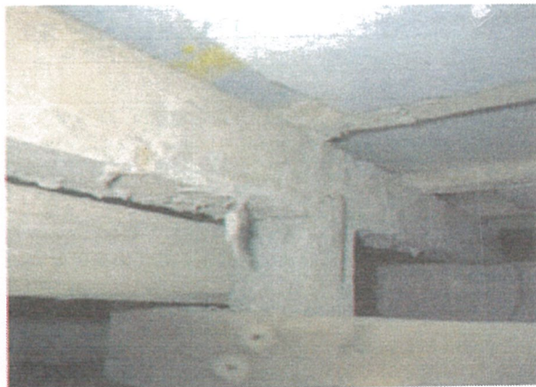
写真5 台所大引の蟻害
