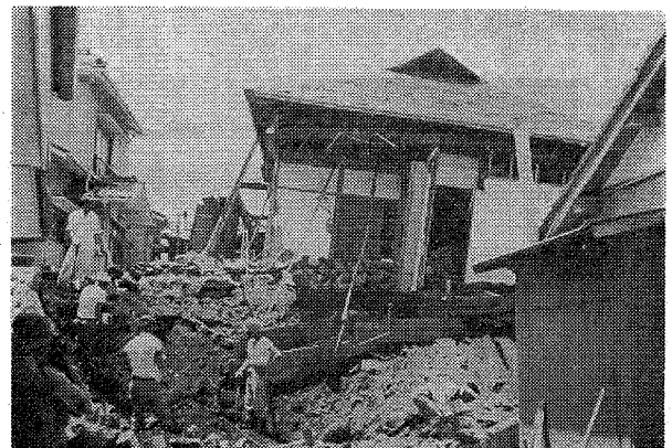
写真15 石垣による住宅の崩壊と建物の被害（入間地区）
