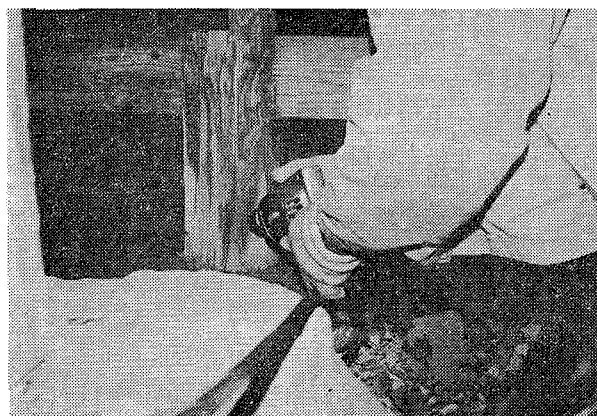
柱 の 穿 孔 処 理
