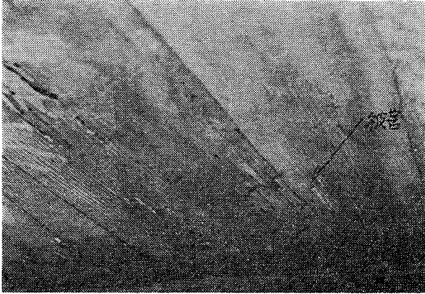
床板の被害
