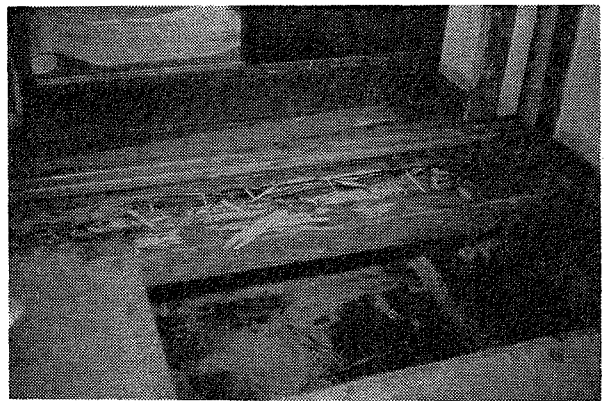
写真17 敷居の被害。
