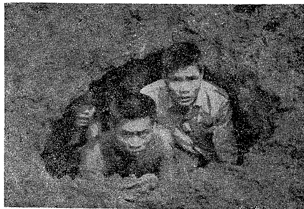
写真13 黒翅土白蟻が堤防につくった巣によってできた空洞
