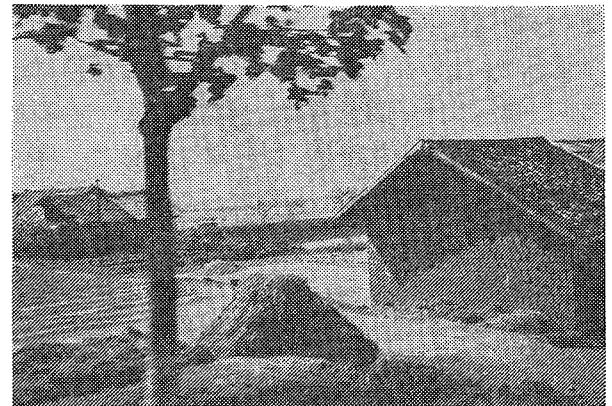
写真18 日干し煉瓦の建物
