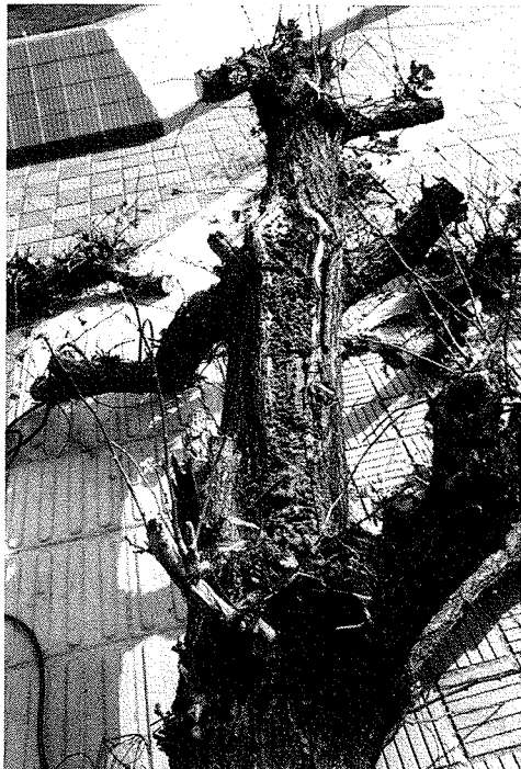
樹幹内部の喰害
