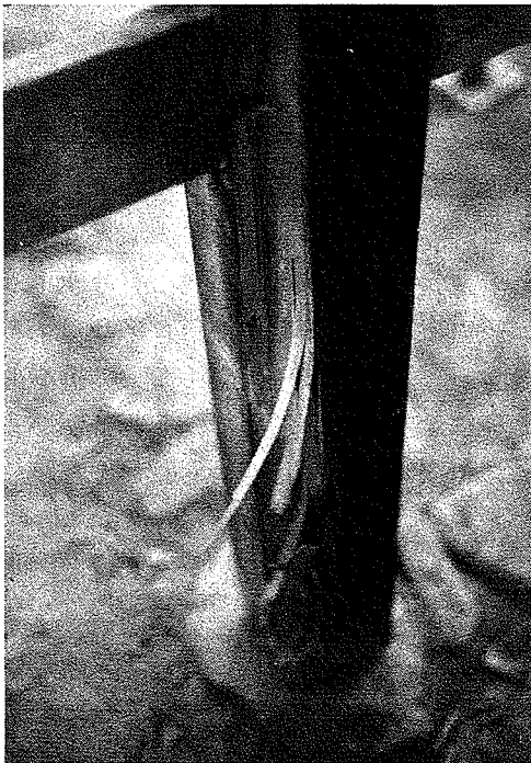
写真三 桂離宮縁束板面におけるシロ アリの薄紙状食痕
