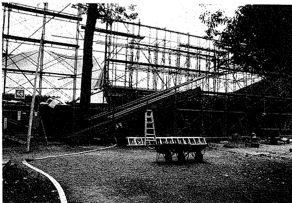
写真一一 桂離宮の燻蒸(新御殿と旧役所の建造物被覆燻蒸：側面)
