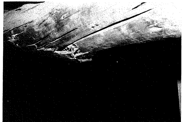
写真六 桂離宮中書院小屋梁の折損部 (キクイムシ被害で、荷重のため折れたもの)
