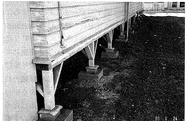
写真—8 ハワイ大学 Tamashiro 実験室の建物に取付けられた防蟻板
