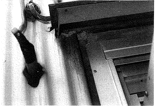
写真13 かもいと柱の部分につくられたイエシロアリの蟻道(土)(C家の物置小屋)
