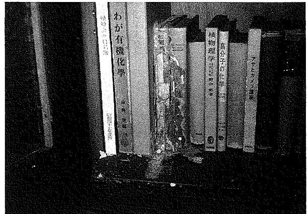
被害部門 2位 西村 政明 「シロアリ ド根性！に敬服…。」 (本棚の被害)
