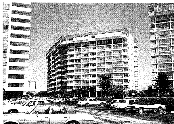
写真10 イエシロアリによる被害をうけているマンション群 (フロリダ州)。
