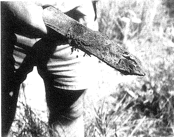
写真5 無処理マツ杭のシロアリ食害（ブリスベーン市近郊，1986年9月から約6カ月間の試験）。
