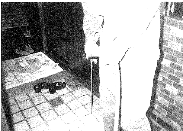
写真2 玄関の上土壌処理
