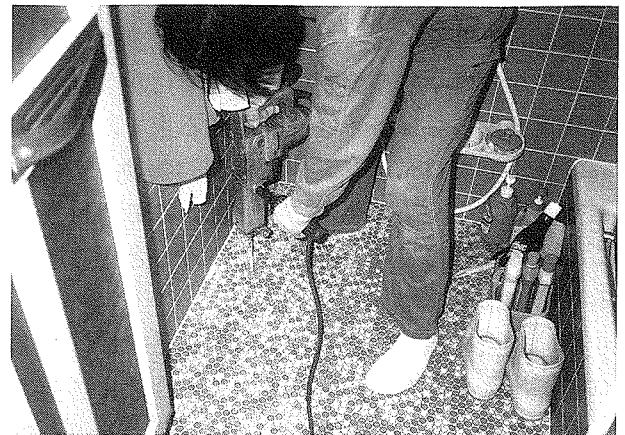
写真4 浴室スラブ下穿孔処理
