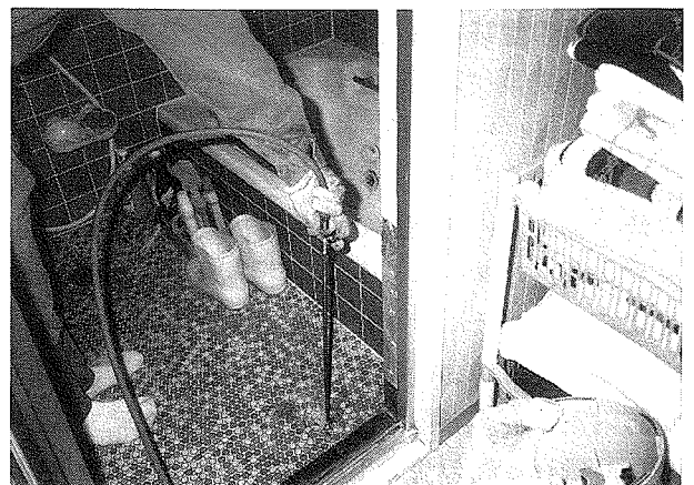
写真5 浴室スラブ下注入処理
