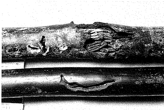
写真2 イエシロアリに食害された信号用ケーブル
