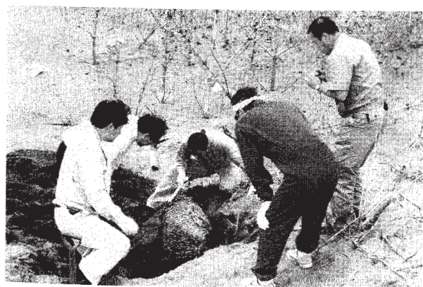
写真1 館山市平砂浦海岸防風林で発掘中のイエシロアリの巣
