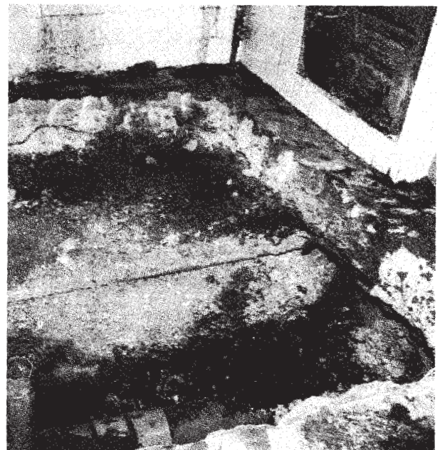
写真3 館山市州宮で厨房のコンクリート下につくられていたイエシロアリの巣（約100×90×50cm）
