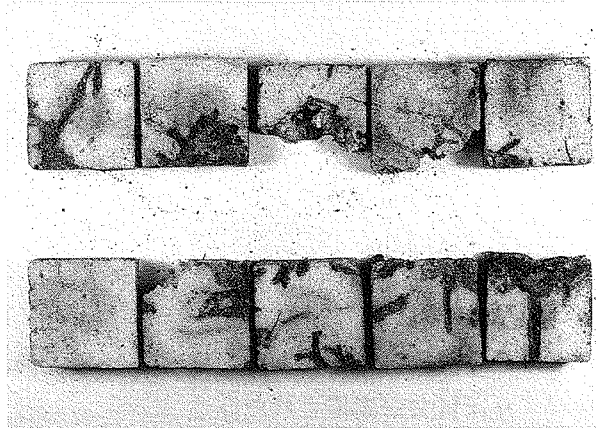
写真8 硼酸10%混入試験体 (1999年11月9日)
