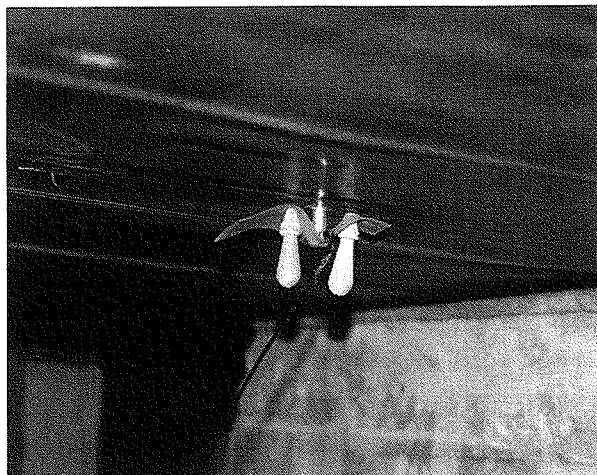
写真1 床パネルの下側、防蟻シートを介して根太にとり付けたAEセンサ。センサはゴムバンドとピンでとめてある。
