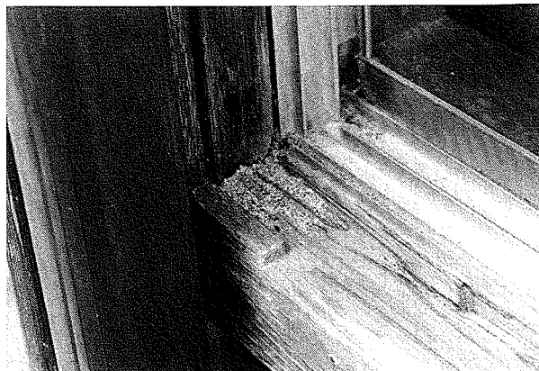
写真4 雨戸および戸袋周囲に積もったアメリカカンザイシロアリの糞。
