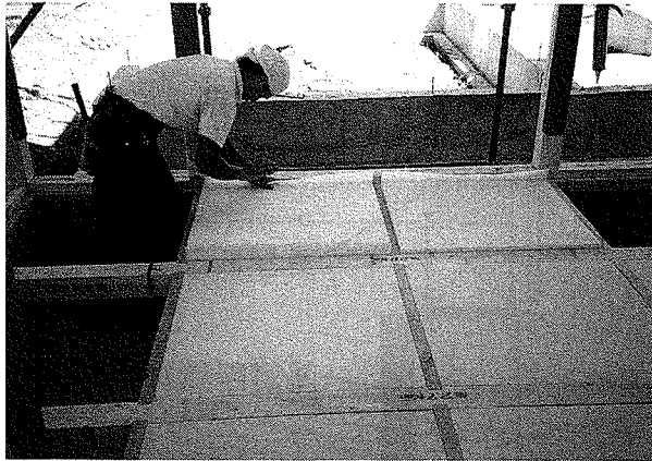
写真1 床断熱施工
