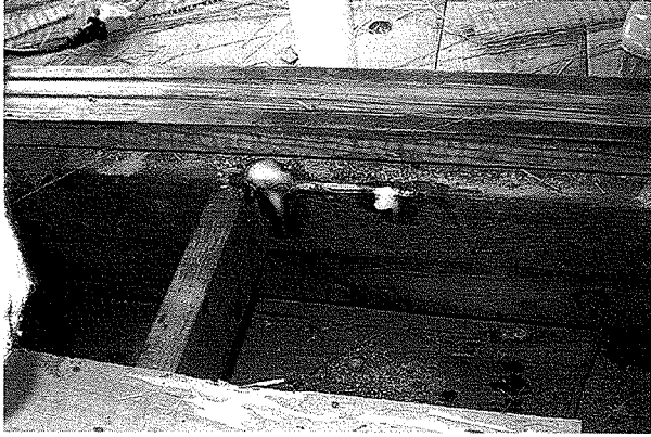
写真7 2階桁, 根太の処理
