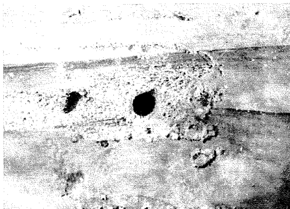
写真4 ダイコクシロアリの孔
