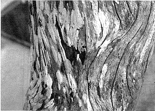
写真14 柱被害
