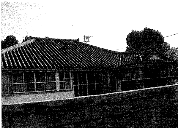
写真10 木造赤瓦ぶき住宅
