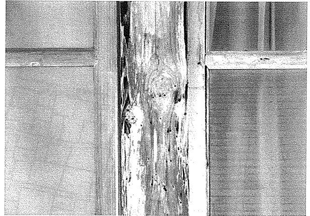
写真13 柱被害
