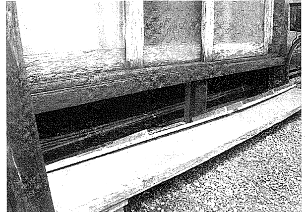
写真23 床下の換気
