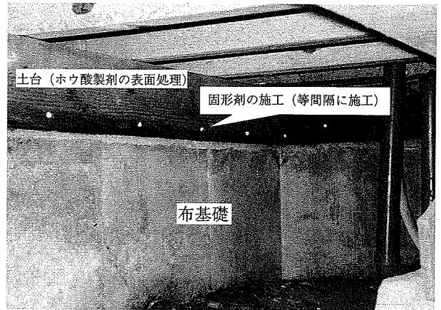
写真5 土台の表面処理と固形剤の施工例
