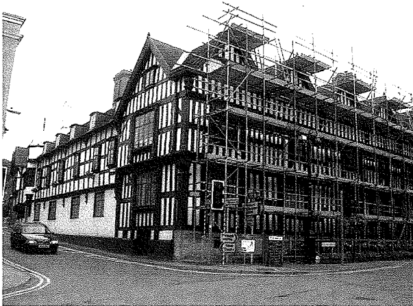
写真3 補修・修繕によって長寿命を保っている木造ホテルの例 (Ledbury)
