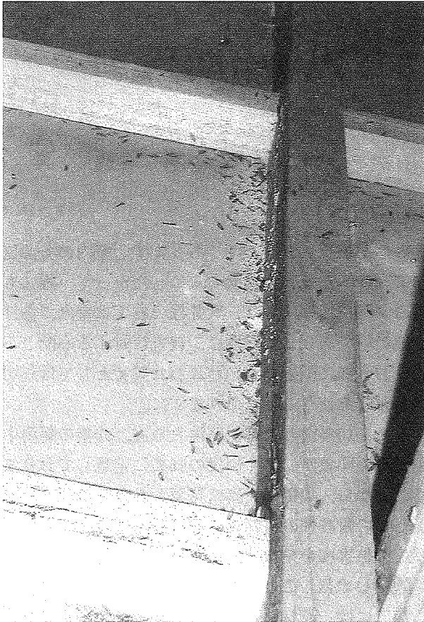
写真7 断熱材下の翅、虫糞及び木粉
