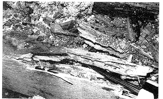
写真6 日本最北のシロアリ被害家屋（集合煙突周辺）
