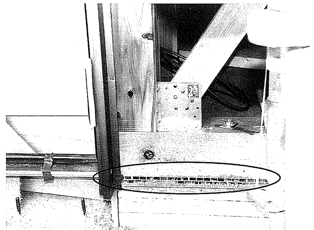
写真4 土台下スリット工法の外周部基礎まわりのねずみ阻止・防虫ネット
