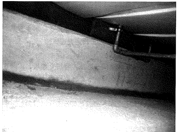
写真8 基礎内周への施工
