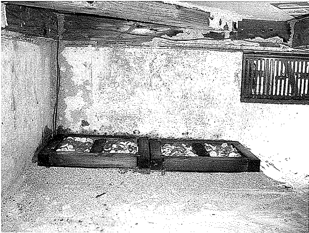
写真13 プリングボックス 2 個設置
