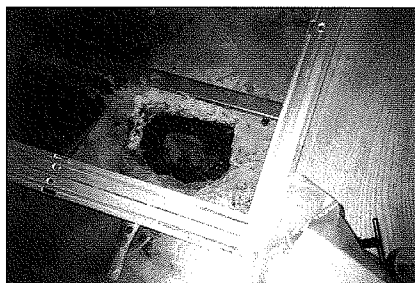
写真23 収納庫の下 コンクリートを ハツって土を確認
