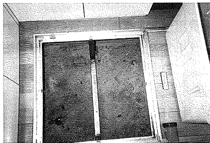
写真10 1階床下収納庫箱が入るだけのスペース
