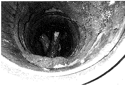
写真31 マンホールの中
