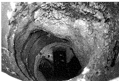
写真22 マンホールの中 拡大写真
