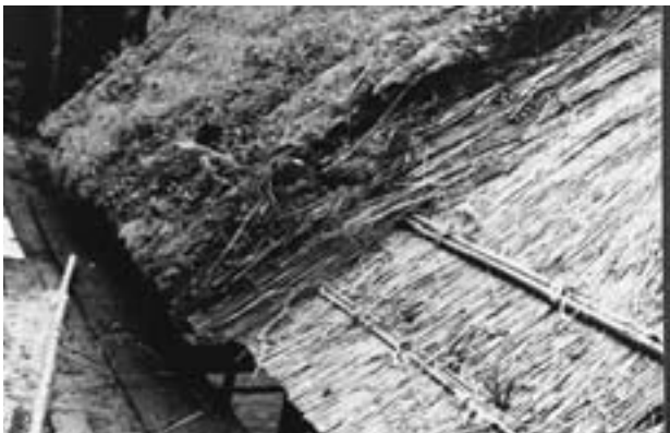
図15 厚く堆積した土壌層を持つ御塩殿屋根
