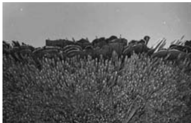
図4 一般的な茅葺き屋根（府中市郷土の森博物館内越智家住宅）と軒先の樹皮混入の様子。軒裏が地表面と平行に作られており、外部から軒裏を見ることはできない。樹皮混入により軒先部分では屋根内部深くへの雨水の浸透がない。
