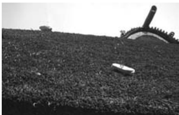
図18 鳥類による引き抜き防止策の例 上：旧富岡家住宅，釣り糸 下：旧島田家住宅，アワビのカイガラ
