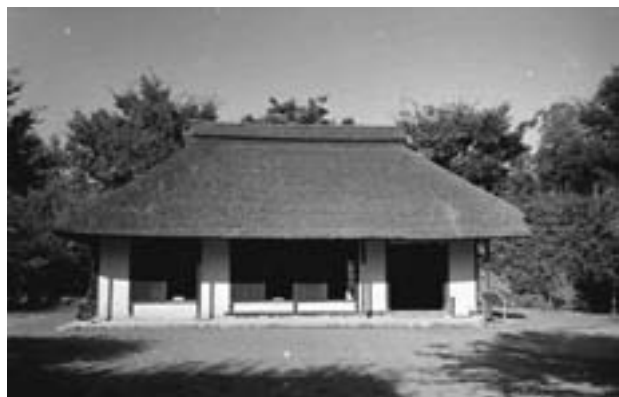
図4 一般的な茅葺き屋根（府中市郷土の森博物館内越智家住宅）と軒先の樹皮混入の様子。軒裏が地表面と平行に作られており、外部から軒裏を見ることはできない。樹皮混入により軒先部分では屋根内部深くへの雨水の浸透がない。
