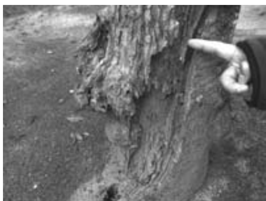
写真12 被害状況（サクラ）
