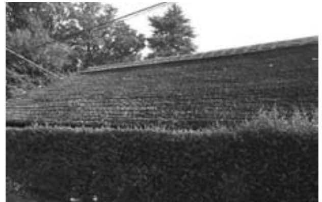
図8 旧島田家住宅周囲の植栽帯。植栽帯は屋根より低いために、屋根は乾燥され易く劣化が進行し難い。
