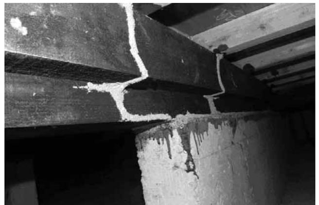
写真6 床下土台の処理状況と蟻道
