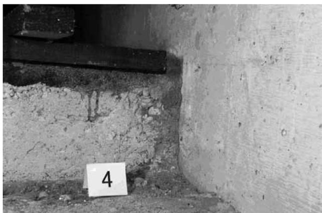
写真9 玄関床下の部分処理部蟻道
