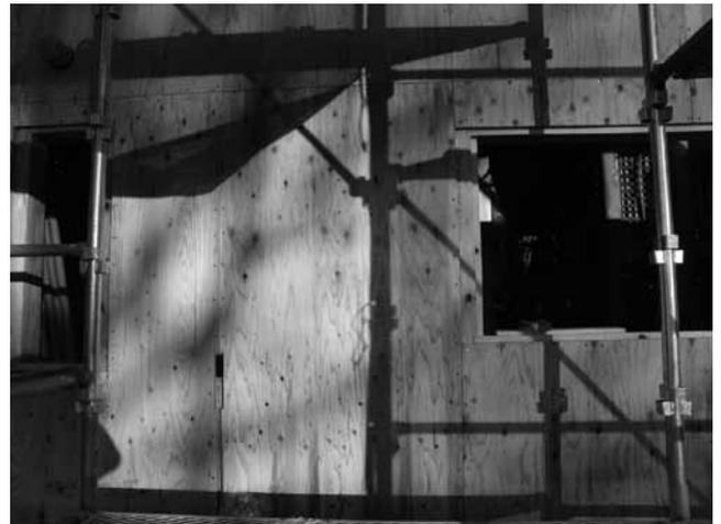
図5 実験住宅西面の耐力壁に使用した厚物構造用合板(右側窓の左隣,中央の合板が加圧注入合板。その合板の両隣が接着剤混入合板。)
