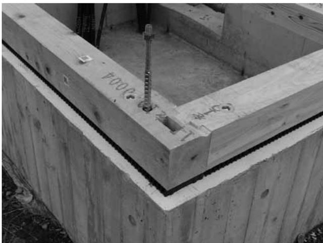
図4 実験住宅の土台(左側:ヒノキ製材,右側:ヒノキ集成材)
