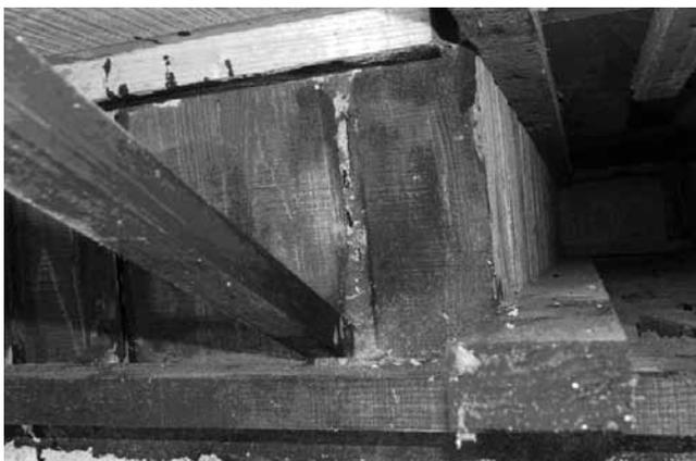
写真7 玄関床下蟻道に塗布されたホウ酸製剤
