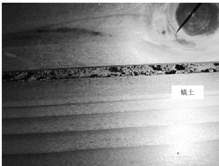
写真7 E9室内側の壁面の様子 (激しい漏水痕と蟻土が存在)
