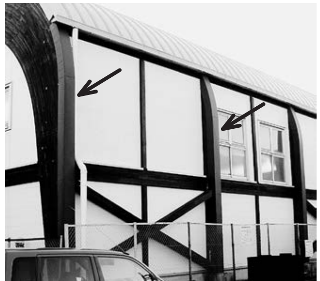
写真2 北側外周壁のメインフレーム（板金被覆）
