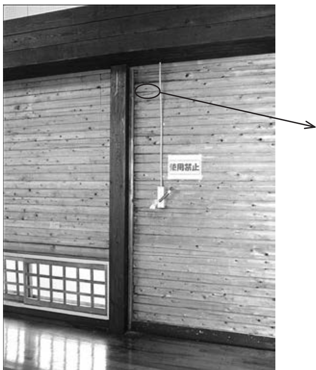
写真7 E9室内側の壁面の様子 (激しい漏水痕と蟻土が存在)
