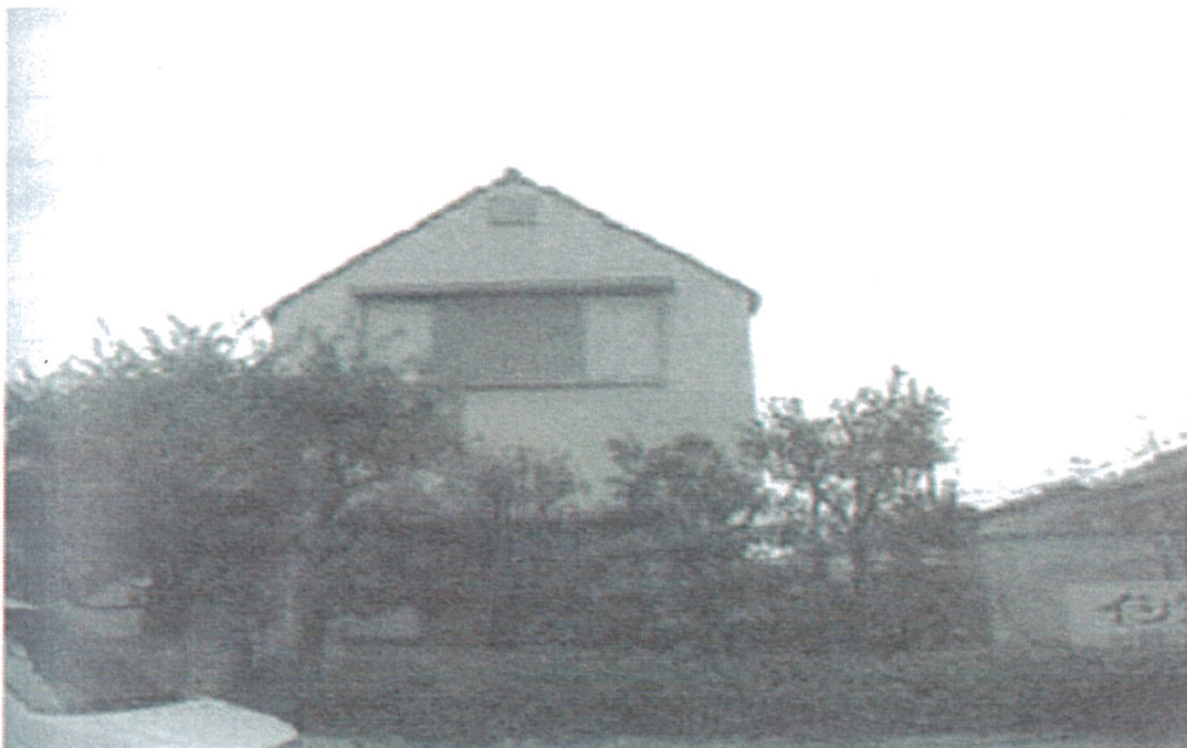
写真 No.1 東側外観
