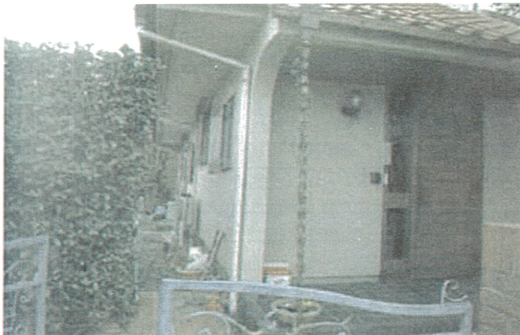
写真 No. 3 玄関周り
