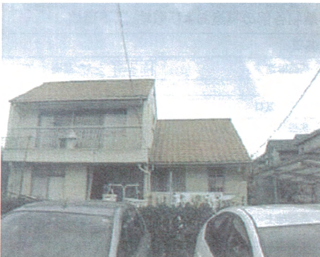
写真 No.2 南側外観
