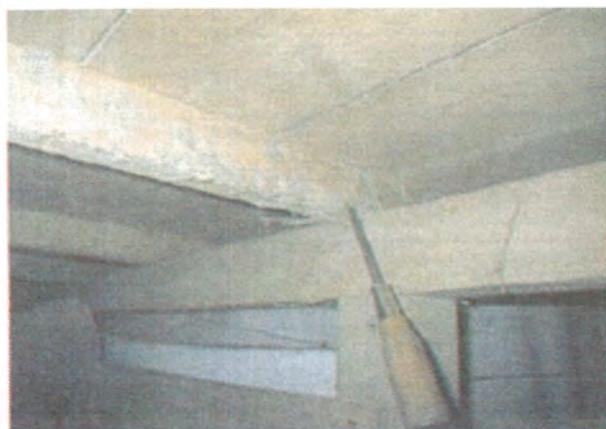
写真6 台所根下の蟻害
