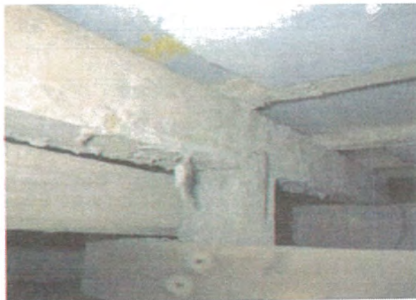
写真5 台所大引の蟻害
