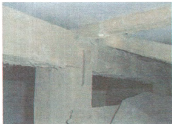
写真4 台所大引の蟻害
