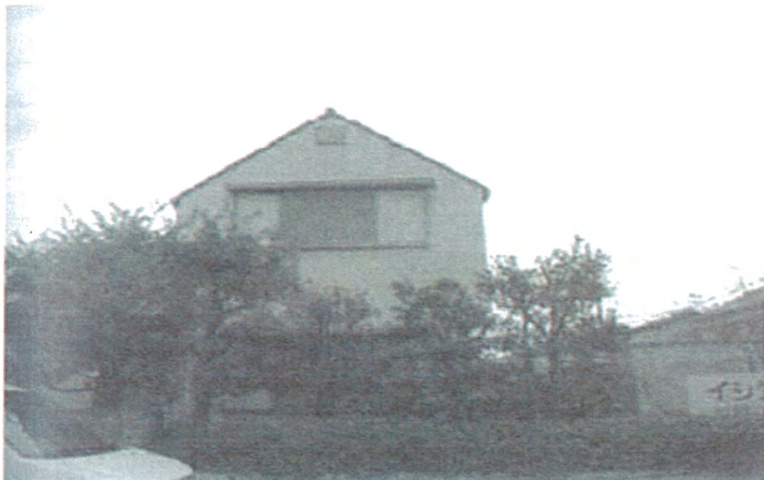
写真 No.1 東側外観
