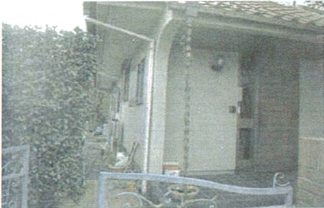
写真No. 3 玄関周り
