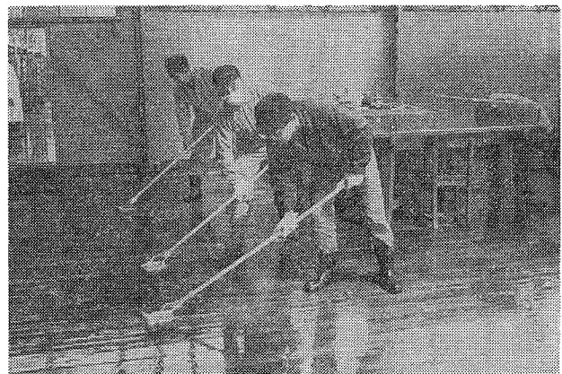
写真4 一般家庭では刷毛で塗布するが、広い面積の場合はバケツに薬液を入れてモップで塗布する
