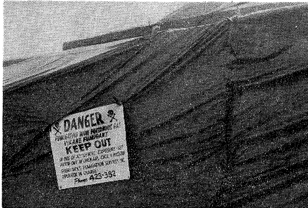
写真5 シートの継なぎ合せと警告用掲示
