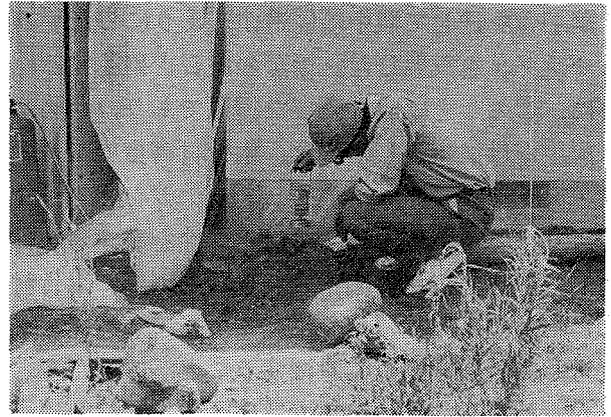
写真6：Halide leak lamp でガス漏れを探知しているところ
