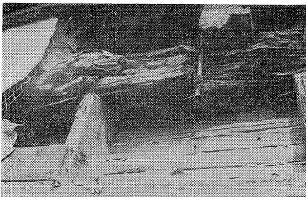
写真10 けたと小屋はりの仕口部 内といよりの雨もりにより腐敗し、羽子板ボルトが浮いている
