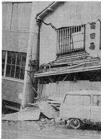
写真5 隣家の鉄筋コンクリート造の傾斜により破壊された木造家屋
