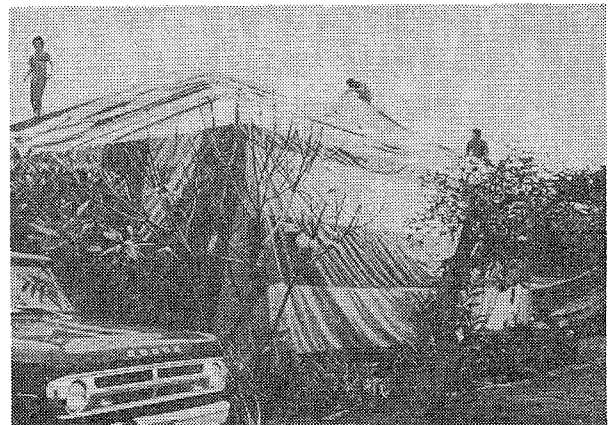
写真一 6 天幕燻蒸作業
