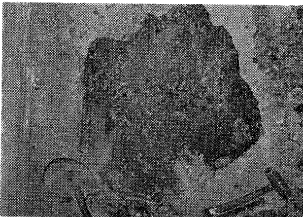
写真20 コンクリートスラブの下に造られたイエシロアリの巣
