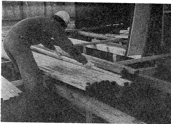
写真8 未取付けの根太材の四面に吹き付け処理
