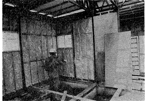
写真5 窓台までの高さのタテ枠内に対する処理施工
