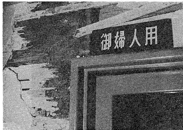
写真12 デパートの5階壁に見られた巣
