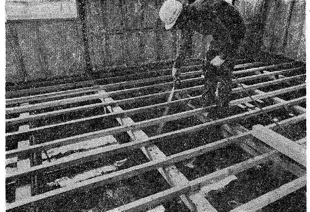
写真18 床下全面に万遍なく土壌処理を行う
