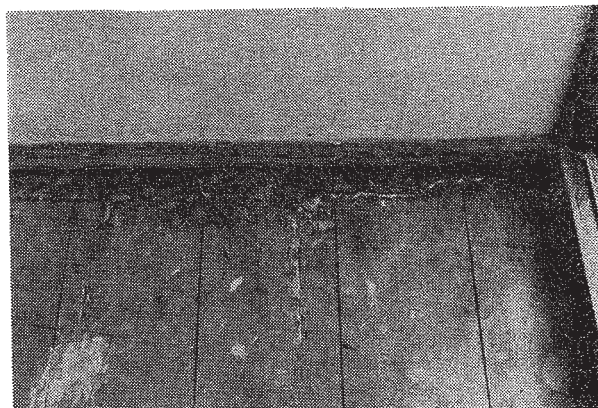
写真2 床板の被害
