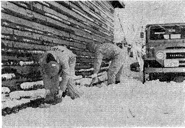
雪中での施工
