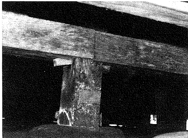
写真8 写真6の建物の床下
