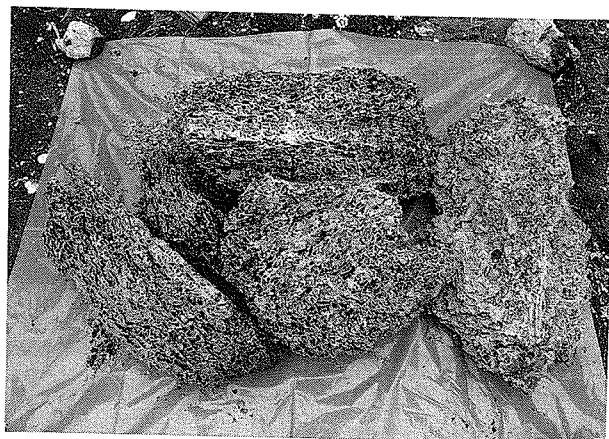
写真17 浴室の洗場タイル下から摘出されたイエシロアリの巣
