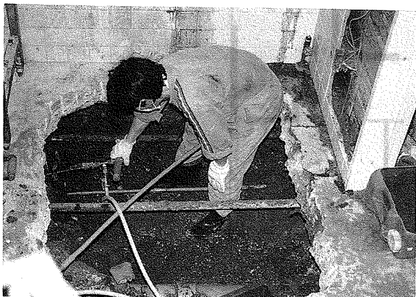
写真13 シロアリ巣を除去した周辺に防除薬剤を注入しているところ
