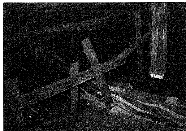
第6図 小屋組の梁が被害で落下している
