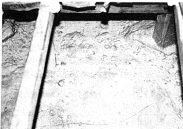
写真一2 施工後の状況
