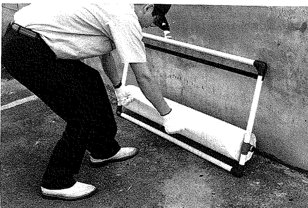
写真-1.1 布基礎に立て掛けてターメッシュを引き出す
