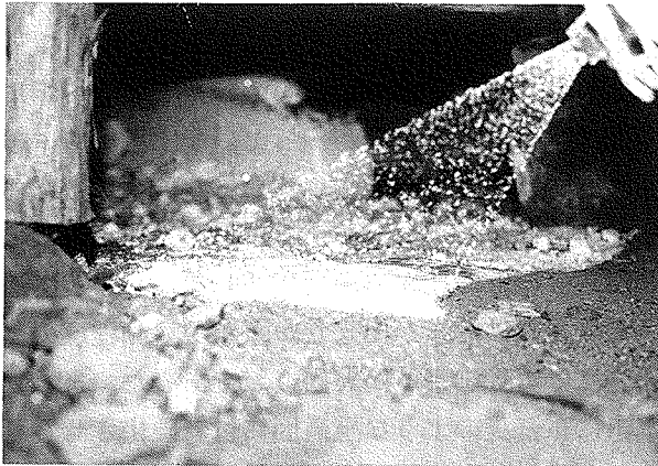
写真一1 床下での施工状況
