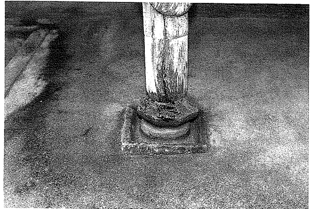
③ 拝殿の柱下基礎石
