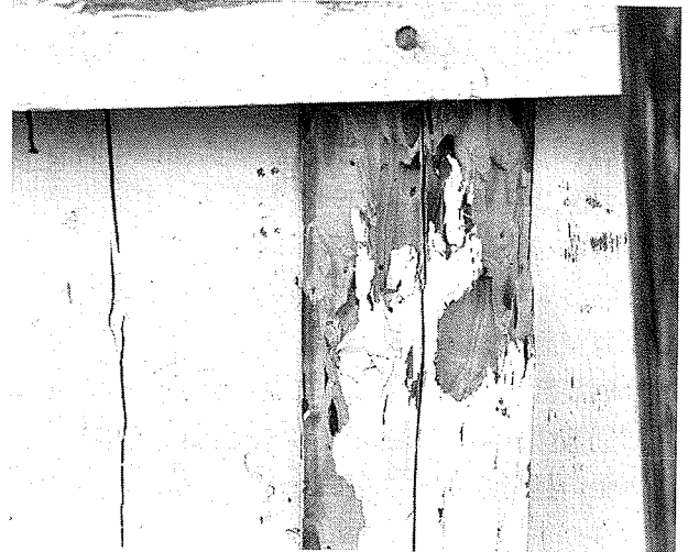
写真 5 外部つみみ板の被害
