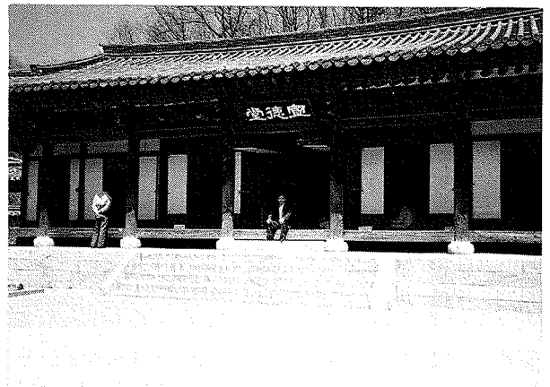
写真2 韓国民俗村, 官衙 (地方庁) の建物, このように多くの木造建築物は礎石を高く, しっかり置いて, 土台や柱に腐朽, 蟻害が及ばないように工夫されている。
