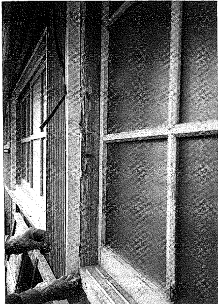
写真1 柱の被害
