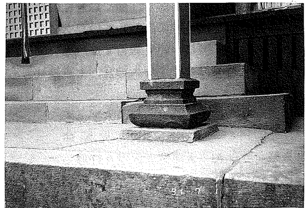
本殿の基礎石
