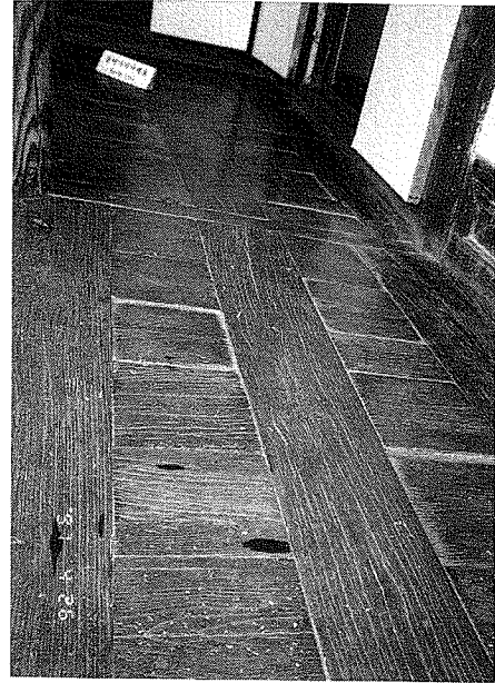
写真4 民俗村，講堂や大きな家の廊下の床板，組合せ方に特徴がある。
