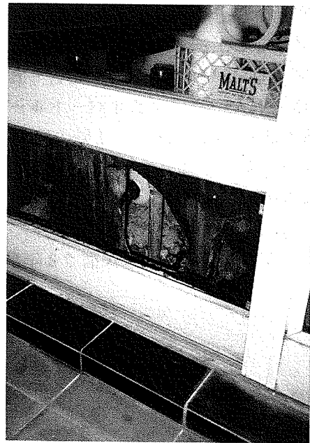
写真2 配管の見える浴槽周り
