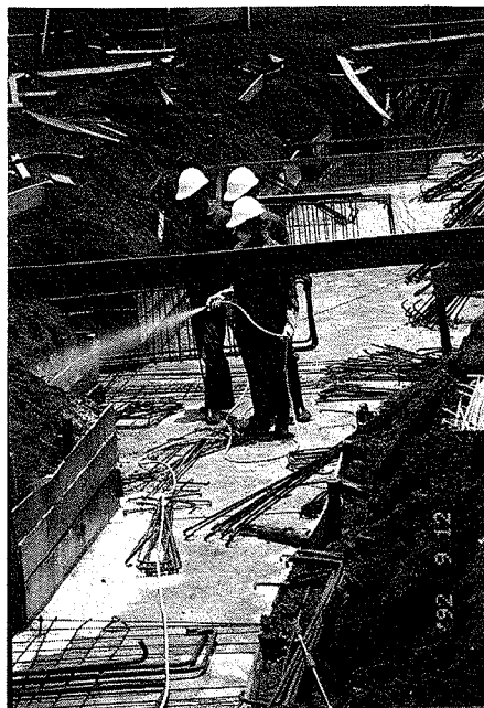
写真5 薬剤散布をしている
