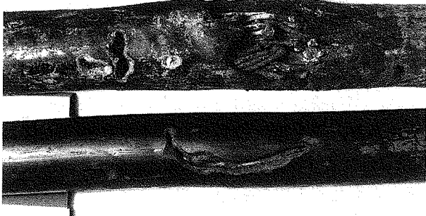
図11 イエシロアリに食害された塩化ビニル被覆ケーブル
