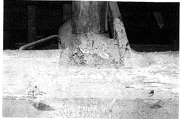
写真2 イエシロアリにひどく食害された崇福寺三門の梁材
