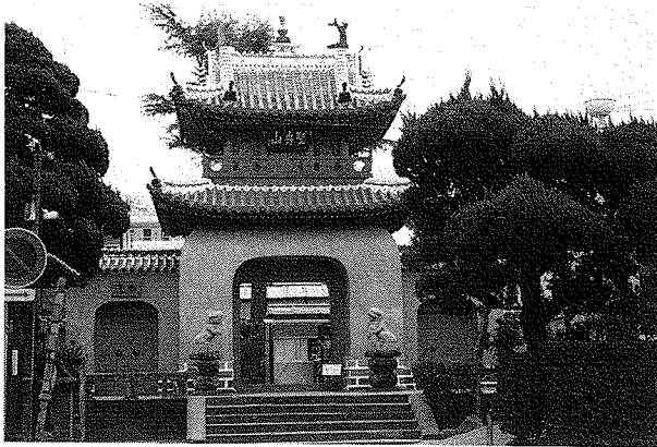
写真1 シロアリ被害がひどく解体駆除工事が行われた崇福寺三門（重要文化財）
