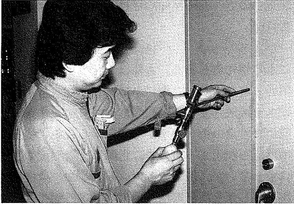
写真117 炎色反応法によるガス検知器でガス漏れを感知しているところ
