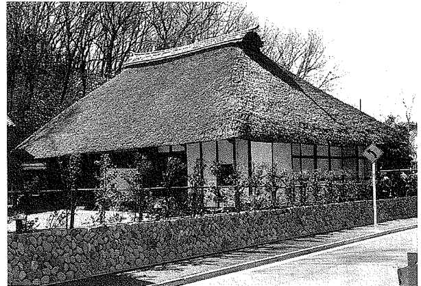
写真83 かや葺建物の被覆燻蒸-1(被覆前)
