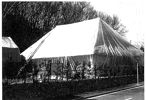
写真84 かや葺建物の被覆燻蒸-2(被覆後)
