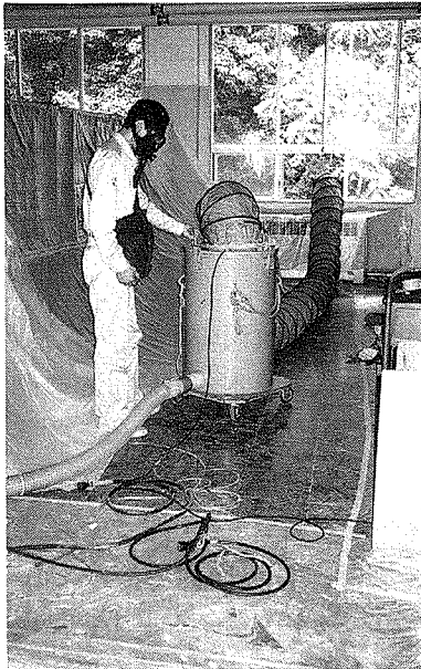
写真97 被覆燻蒸における残留ガス吸収装置を通しての排気
