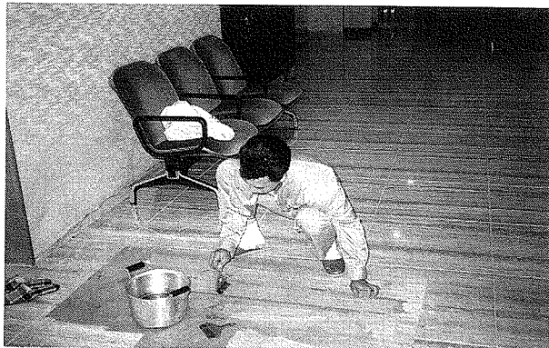
写真101 目貼り用のガス遮断性クラフト紙に糊を塗布しているところ
