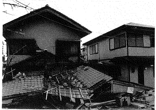
写真一13 全壊した在来軸組住宅（左）と健全なプレハブ住宅（右）（神戸市東灘区本山中町2丁目11）
