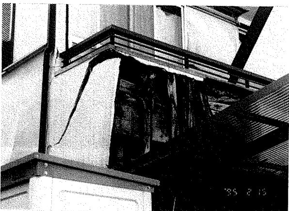
写真一6 2階バルコニー壁内部の腐朽と蟻害（西宮市仁川町3丁目11）
