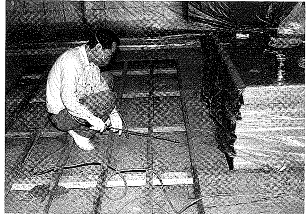
写真12 ベタ基礎へ薬剤散布をした
