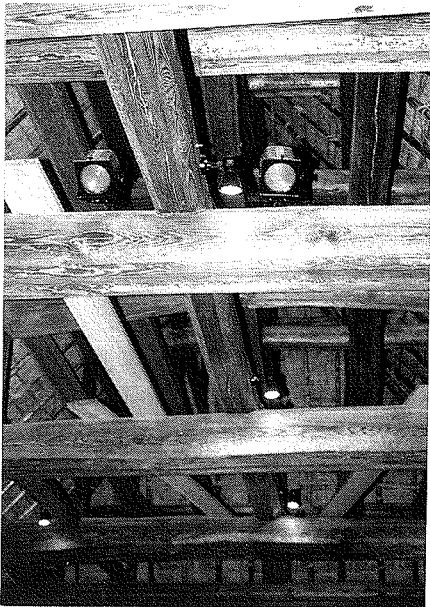
写真1 天井板がなく梁と茅葺き屋根がそのまま見える
