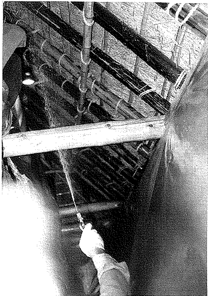
写真10 廊下の天井の茅部分を散布した
