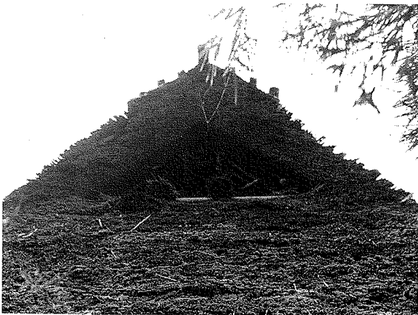
写真2 苔、小植物などで覆われている茅葺き屋根
