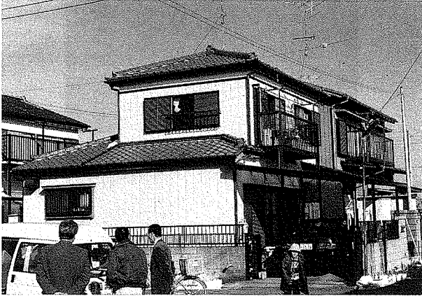
写真1 被害建物の外観（南西方向から撮影。手前がB氏宅、右後方にA氏宅が見える。）
