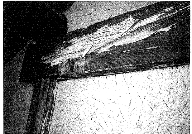
写真2 アメリカカンザイシロアリによる被害(1)
