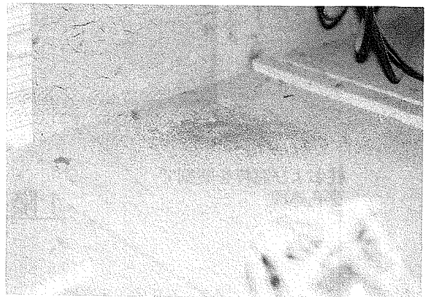
写真21 天井板に排出されたアメリカカンザイシロアリの糞 (B氏宅)
