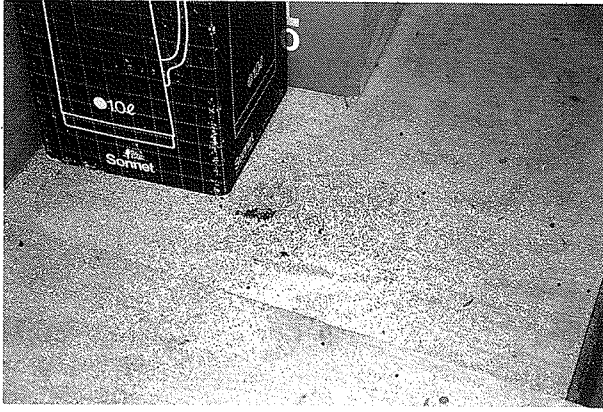
写真8 調査1-1 アメリカカンザイシロアリの虫糞の山
