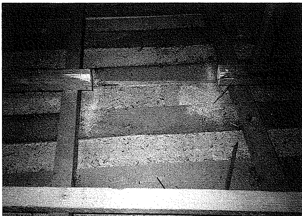
写真1 被害材から排出されたアメリカカンザイシロアリの糞
