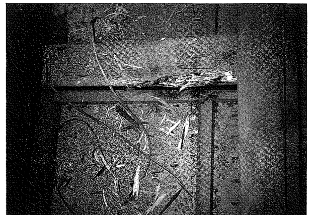
写真3 アメリカカンザイシロアリの被害(2)
