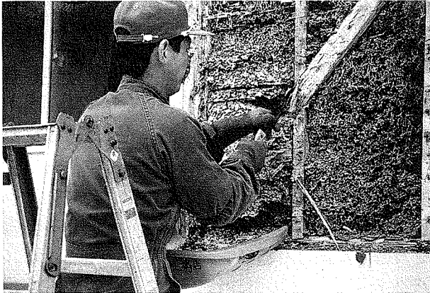
写真7 風呂場外壁の本巣の撤去②
