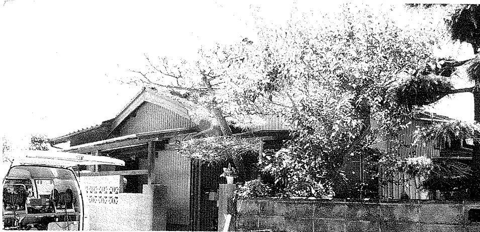
写真1 シロアリ防除作業を実施した木造家屋
