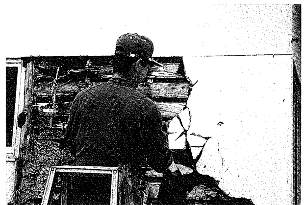
写真6 風呂場外壁の本巣の撤去①
