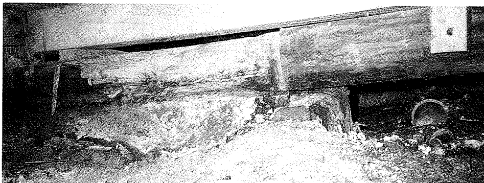
写真2 同上15年前に駆除作業した状態そのままシロアリ発生なし(床下)
