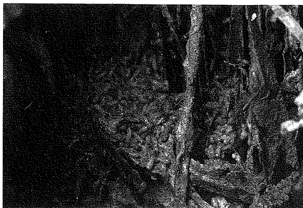
写真15 王台近くの柱根元のシロアリの山
