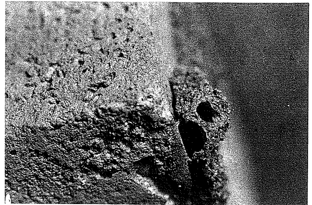
写真41 コンクリート表面につくられたイエシロアリの蟻道（断面）
